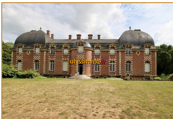
façade du château
